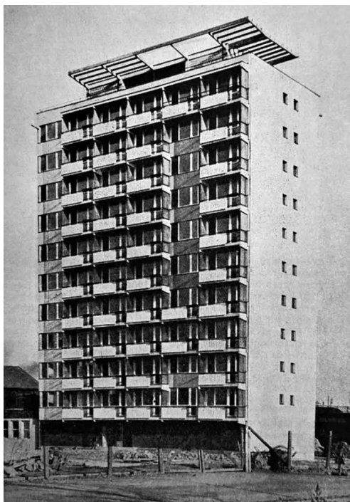
Obrázek 6. František Zounek – Milan Pospíšil, experimentální dům, Brno, Křídlovická ulice, 1958–1961. Reprodukce z časopisu Pozemní stavby IX , 1961, č. 7
