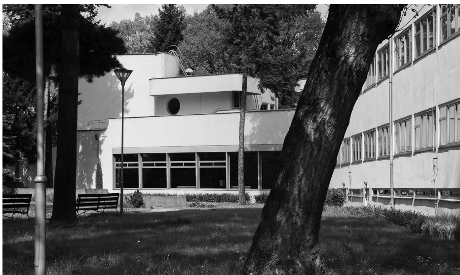
Obrázek 5. Hans Scharoun, hotelový dům v kolonii WUWA ve Wroclawi, 1929. Snímek Martin Podhola, 2016
