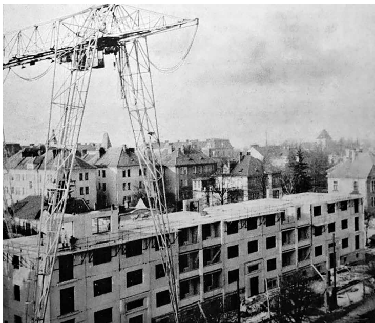
Obrázek 2. Montáž prototypu G 57 v Opavě s pomocí portálového jeřábu, 1958. Reprodukce z časopisu Pozemní stavby VI, 1958, č. 5
