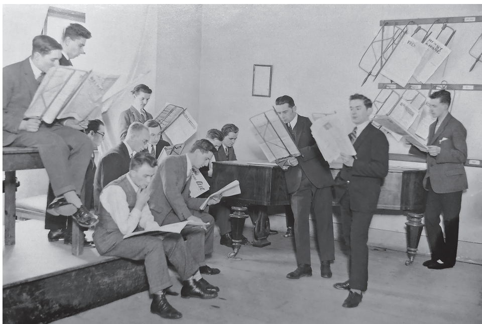
Obr. 6: Čítárna koleje v Donucovací pracovně v Loretánské ulici 180/6 na Hradčanech (AUK, f. Vřestudentský archiv, k. A 314, Masaryk. stud. koleje, před rokem 1929)
