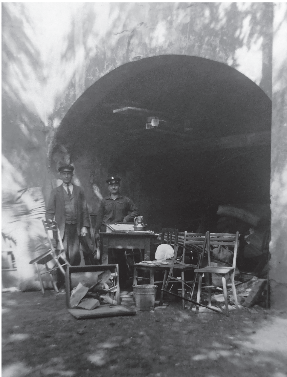
Obr. 12: Exekuce kolejní odbočky v kapucínském klášteře na Loretánském náměstí na Hradčanech v létě 1927. Vlevo stojí pravděpodobně úředník Novotný z magistrátu hlavního města Prahy a napravo od něj jeden ze zaměstnanců hospodářského úřadu hlavního města Prahy a okolo nich se nachází nábytek a vybavení z vyklizených studentských pokojů (AUK, f. Všestudentský archiv, k. A 314, Masaryk. stud. koleje)
