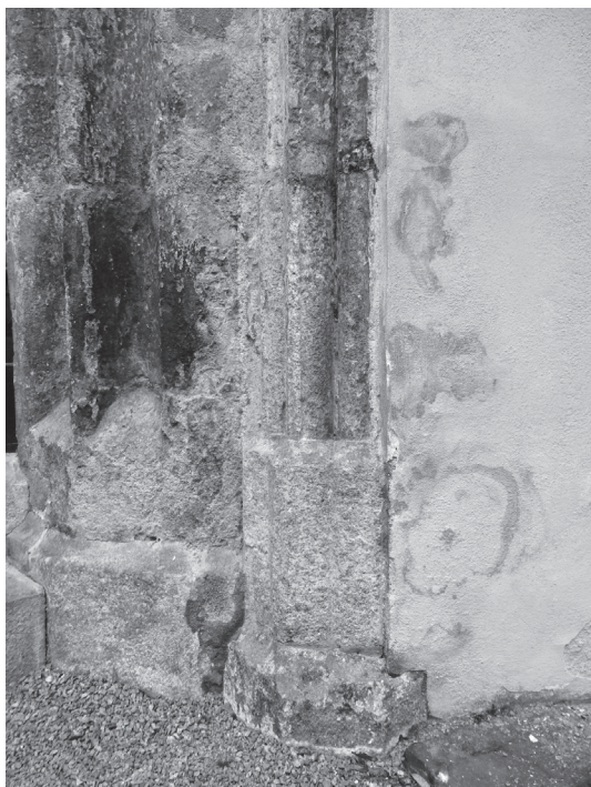
Obrázek 4. Zlatá Koruna, cisterciácký klášter, detail jižní interiérové přípory bývalého studničního stavení, foto: archiv autora, 2021
