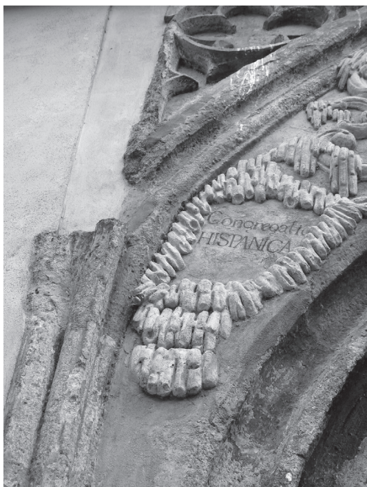
Obrázek 5. Zlatá Koruna, cisterciácký klášter, detail severní interiérové přípory bývalého studničního stavení s náběhem přizdního cviklu někdejšího stropního řešení, foto: archiv autora, 2021
